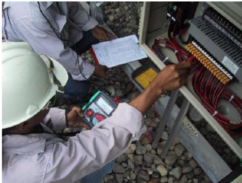
Gambar 10.1 Pengukuran Tahanan Isolasi Sumber: sibay-rb.ru
